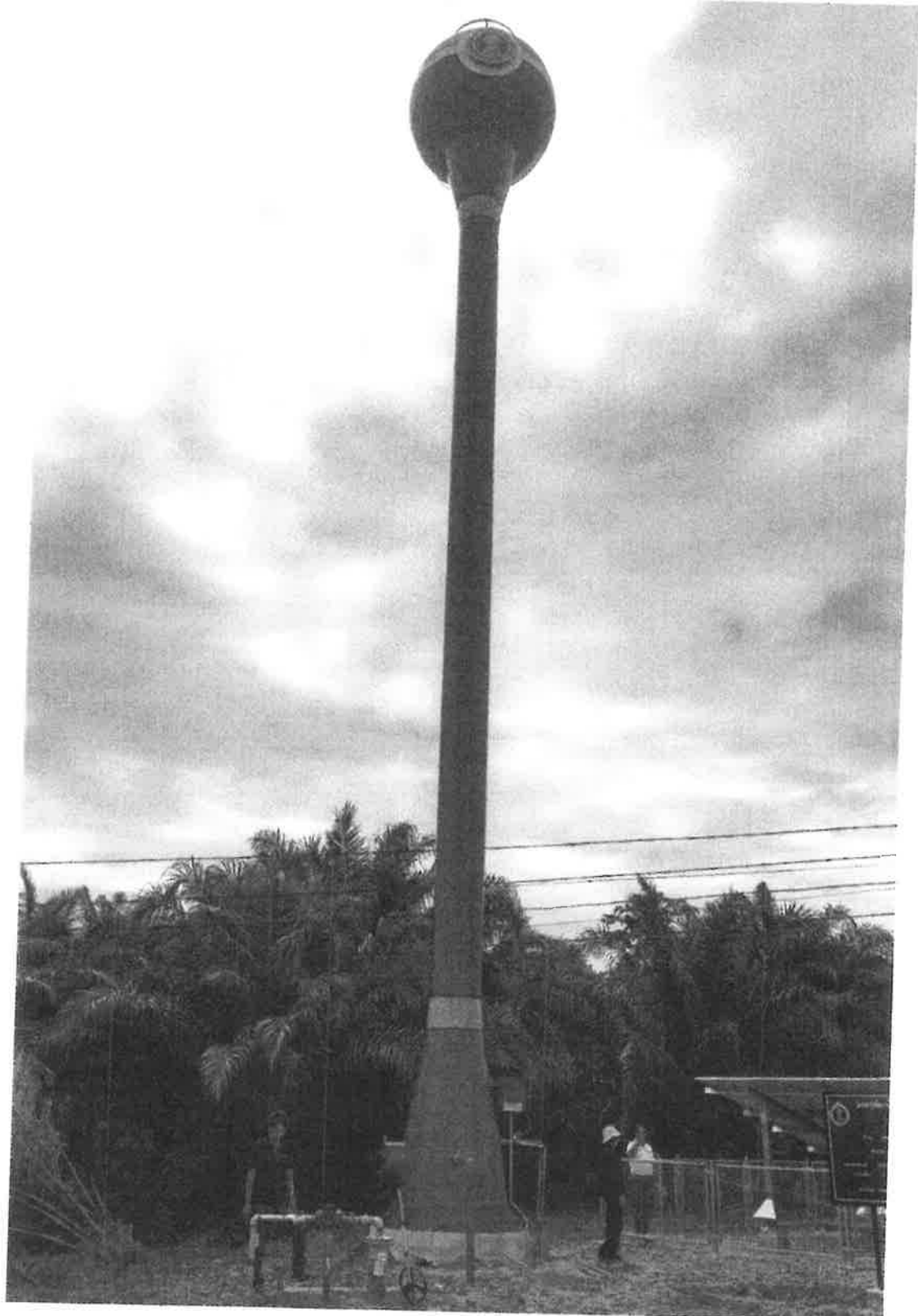
ภาพทอถ้งพักน้ำ พักัด Zone ๔๘Q ตะวันออก ๒๙๒๓๙๕E เหนือ ๑๙๘๘๓๘๓N
